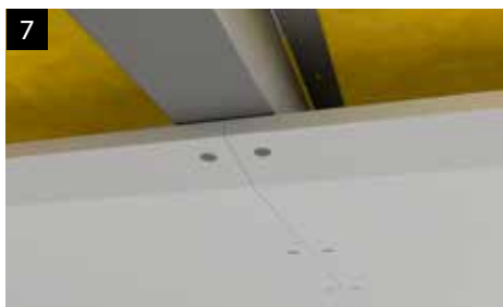
7 Kortkanterna på gipsskivorna skall vara understödda. Vid längsmontage används T-skarv eller plåtbånd. Anslutningar mot vägg tätas med elastisk fogmassa, GSL 600, vid första skivlaget. Fogbredd minst 10 mm.
