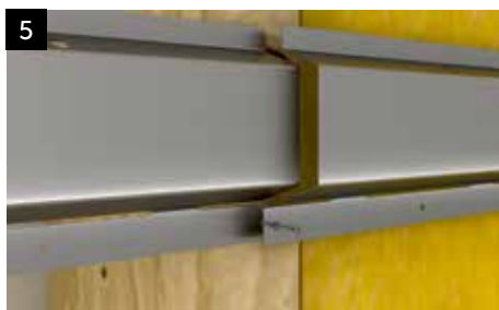
5 Skarvning sker alltid över regel med profilerna kant i kant och de båda förborrade hålen rakt över varandra. Skarvarna bör förskjutas i förhållande till varandra.
